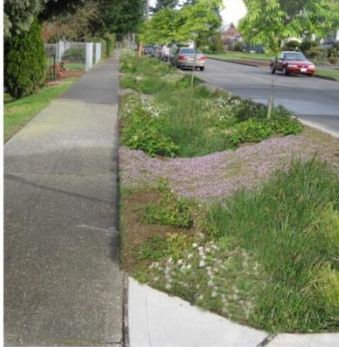
Strassenraum mit Versickerungsstreifen fängt Regenwasser auf und führt dieses Grundwasser und Pflanzen zu
