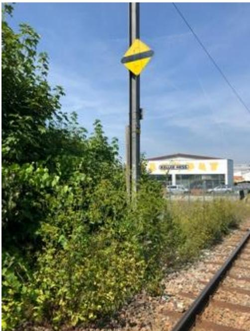
Stromabnehmer-Senksignal links von Gleis 82 bei Mast 110
