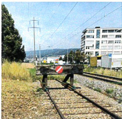
Gleis 84: Bremsprellbock B6 Gleis 82
