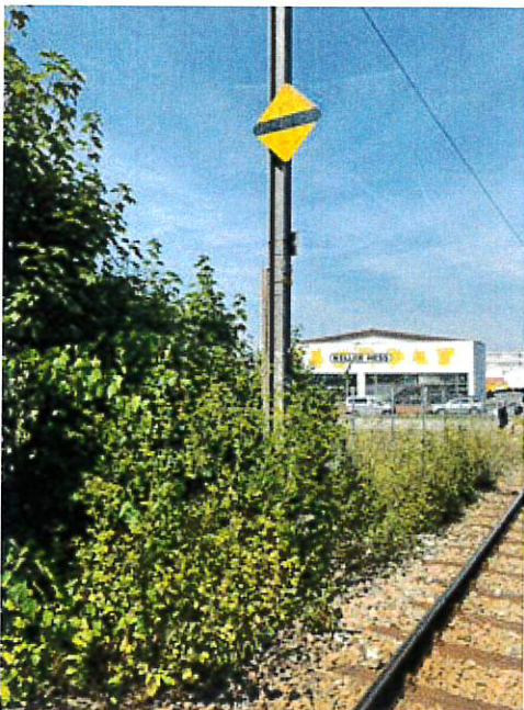
Stromabnehmer-Senksignal links von Gleis 82 bei Mast 110
