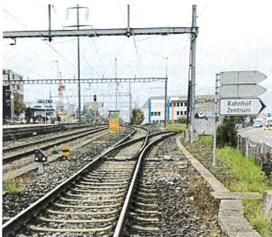
Anschlussweiche 24 Richtung Gleis 67
